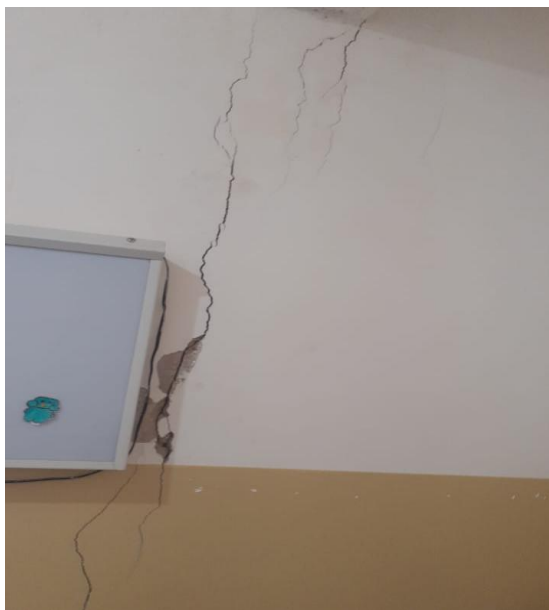
Diversas trincas avançada em paredes e teto
