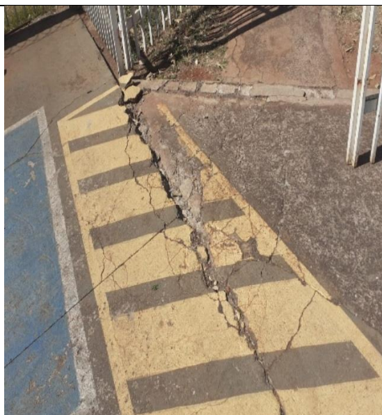
Rampa de acessibilidade danificada, apresentando desníveis e riscos para usuários.
