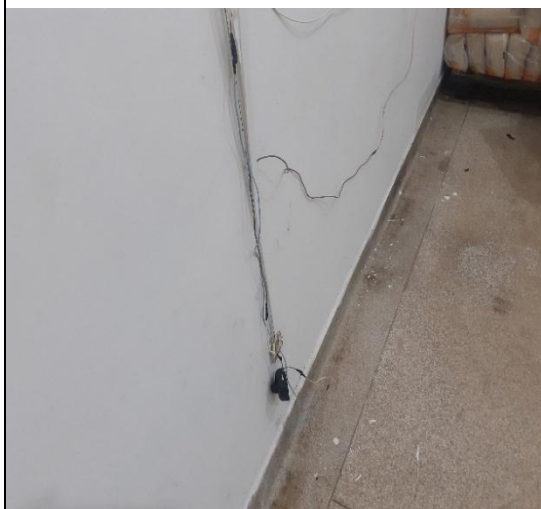
Cabeamento elétrico exposto e diversos pontos na cozinha sem lâmpadas, o que compromete a iluminação adequada para o trabalho e a segurança.
