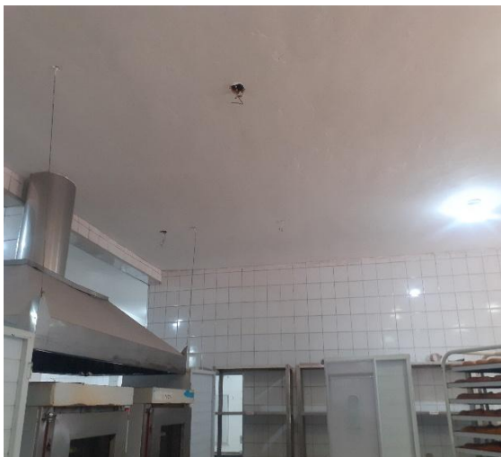
Cabeamento elétrico exposto e diversos pontos na cozinha sem lâmpadas, o que compromete a iluminação adequada para o trabalho e a segurança.
