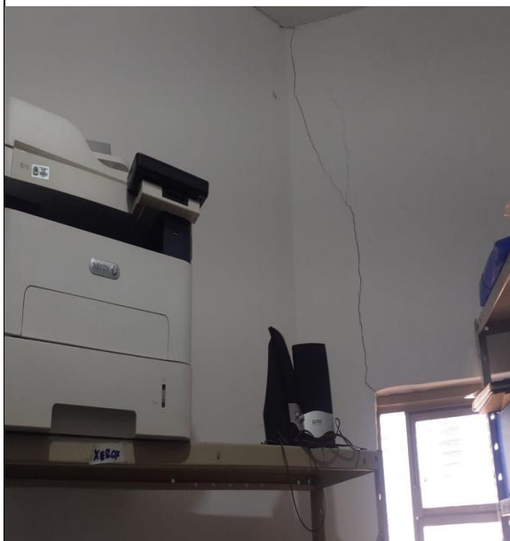
Diversas trincas avançada em paredes e teto
