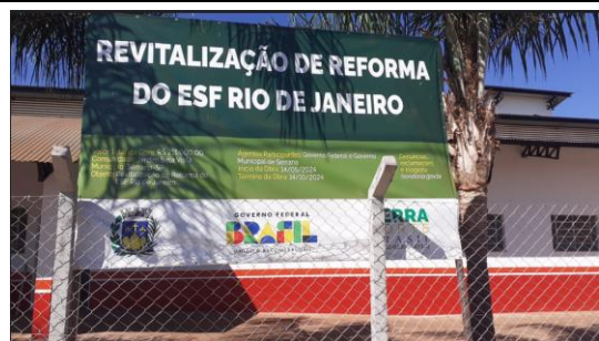
Inspeção in loco em 06/08/2024
