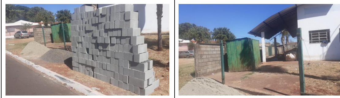
ESF da Rua Victório Valdevite abandonada: data da visita 05/08/2024
