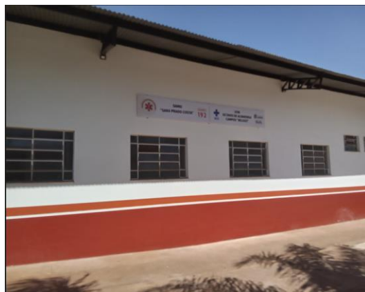
Inspeção in loco em 06/08/2024
